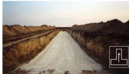
60 m de long, 4 m de large, 2 m 50 de profondeur.
